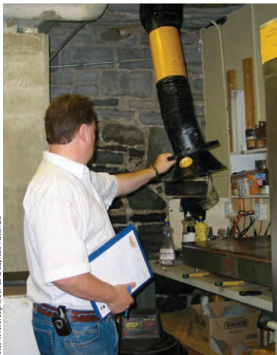
Michel Legris, hygiéniste du travail, teste le système d'aspiration à la source d'un atelier de sérigraphie.
